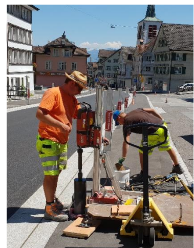
Bohrarbeiten für Poller
