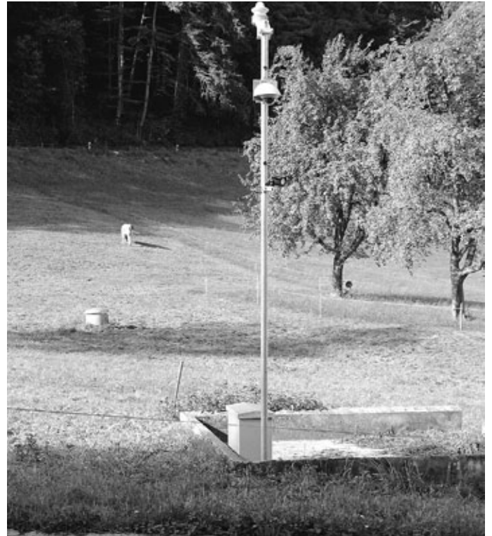
Das Schneewachtgerät liefert den Bauamtsmitarbeitern genaue und zuverlässige Messdaten vor Ort.
